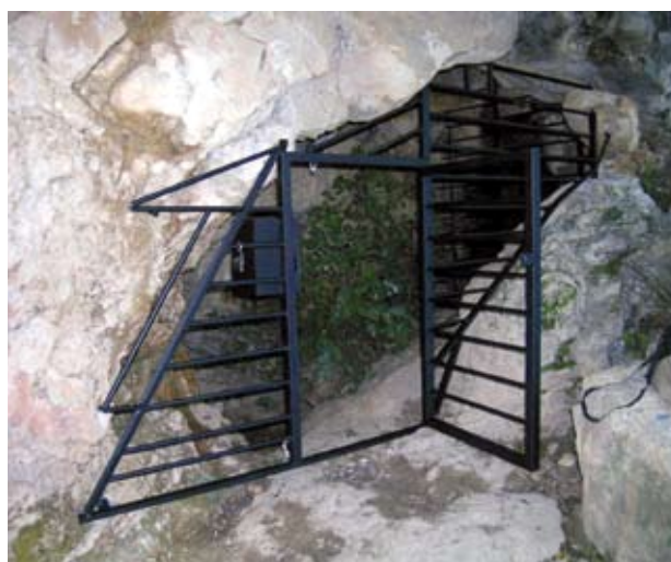
Fig. 7. Cueva del Reguerillo (Patones, Madrid). Cierre de cavidad diseñado para el paso de quirópteros.
